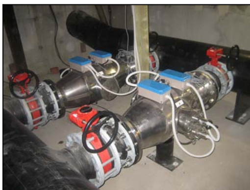
Sistema UV a bassa pressione modello 200/15 Rack Plus. Portata: 350 m 3 /h Trota Iridea: incremento della produzione del 50%
