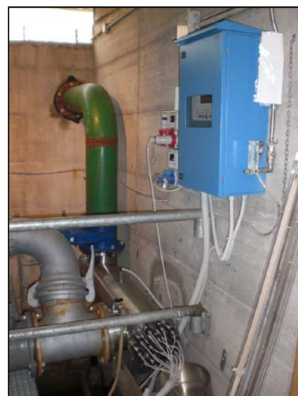
2 sistemi UV a media pressione modello SMP70 Portata: 360 m 3 /h
